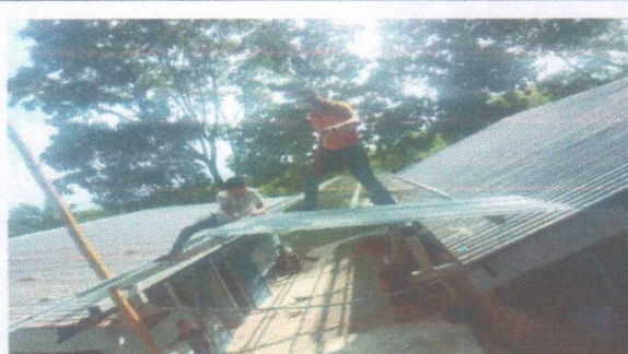
Foto 2: En la foto se observa el cambio techado.
