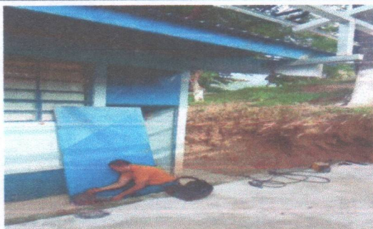
Foto 5: Se observa el cambio de puertas y chapas
