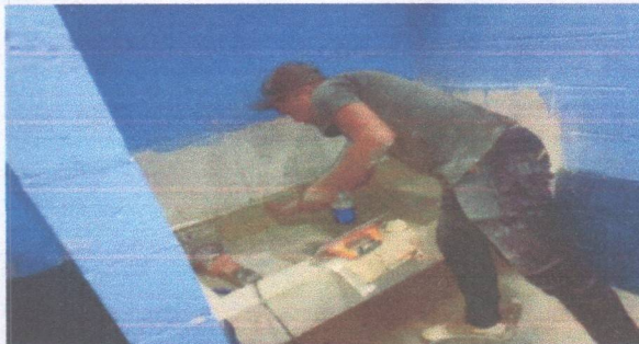
Foto 6: Se observa el cambio de piso y repello a pisos cerámico.
