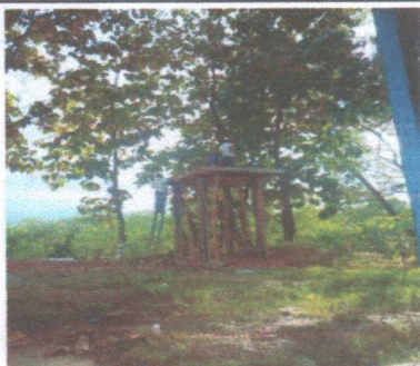
Foto 3: Se observa la colocacion de Columnas del Tinaco
